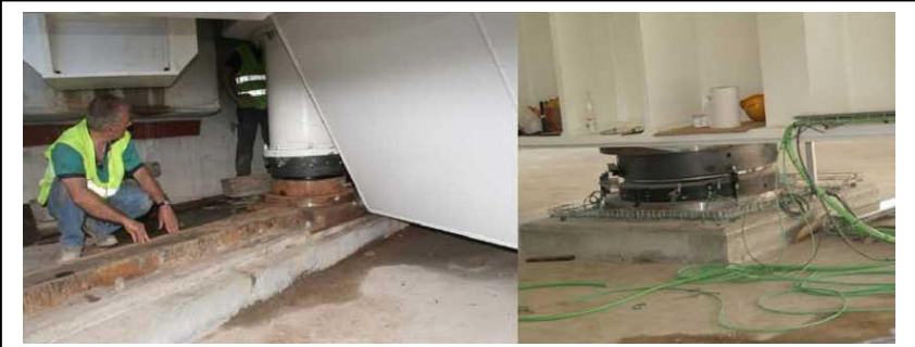
Punto de apoyo Puente Giratorio Valencia.
